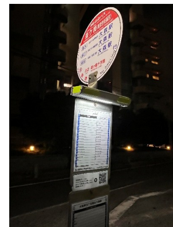
照明を設置したバス停の様子
