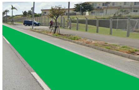
既存バスレーン（規制）の路面舗装
