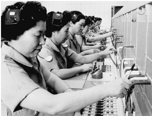
沖縄の電信電話事業は復帰と共に琉球電電公社から日本電電公社に業務が引き継がれ、通話も市外ダイヤル回線が切り替わった= 1972年5月15日
