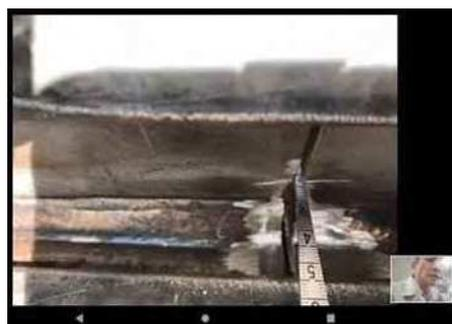
【継手部隙間測定】
