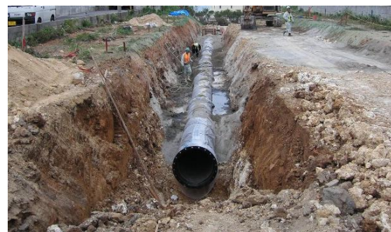
埋設管 (開削工法) 直径0.9メートル
