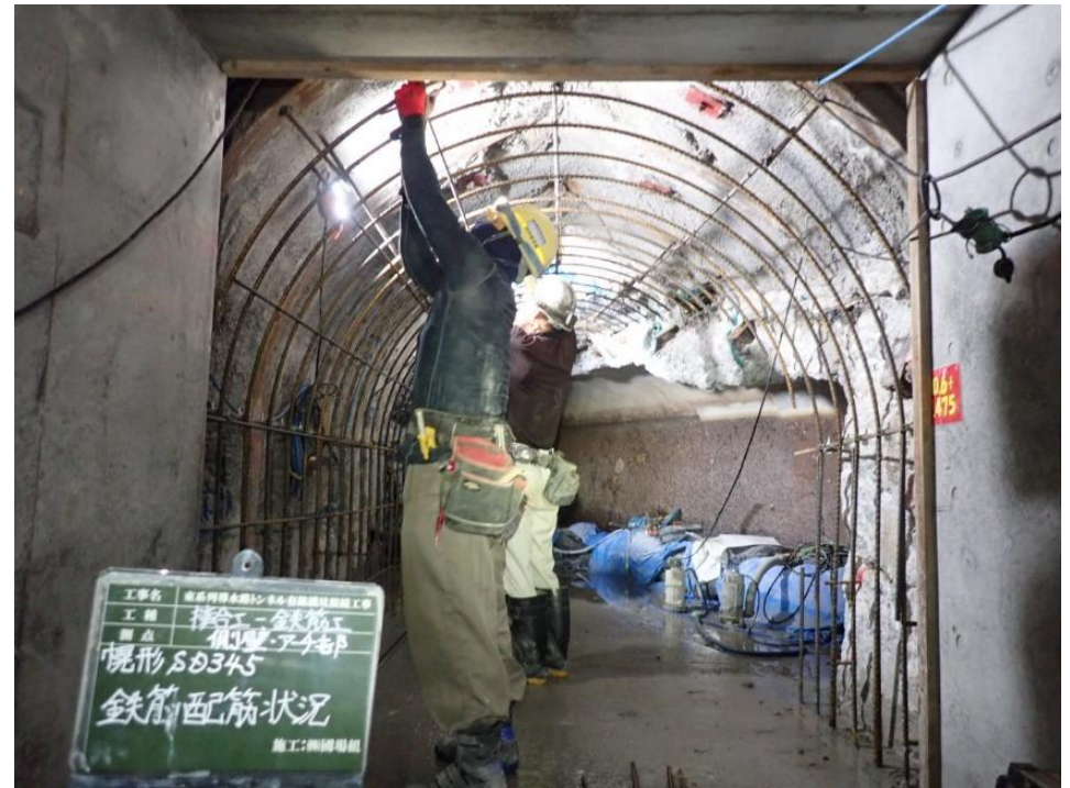
鉄筋配筋状況
