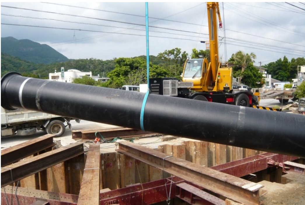
ダクトル鉄管吊り上げ状況
