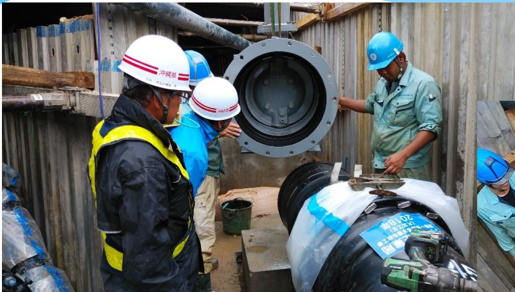
バルブ設置施工状況
