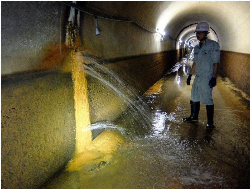
老朽化状況（漏水）
