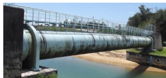
水管橋 (河川横断) 直径2メートル
