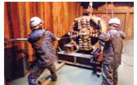
終点に到達した掘進機械 (水道管の設置完了)
