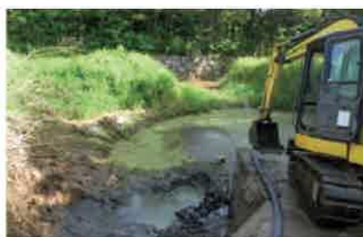
沈砂池の泥上げ
