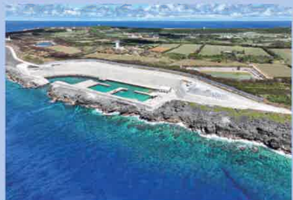
南大東漁港 (北大東地区)
