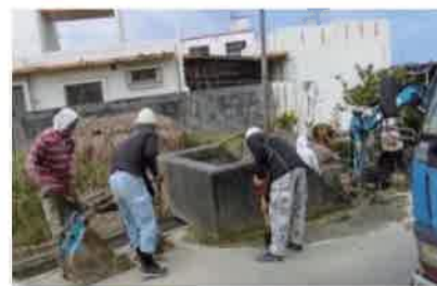
排水路の泥上げ
