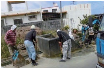
排水路の泥上げ
