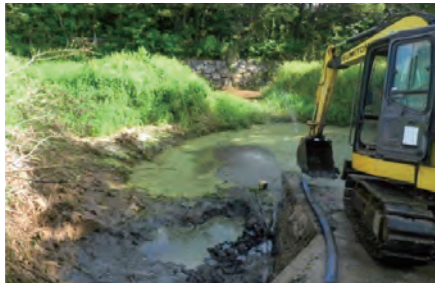
沈砂池の泥上げ
