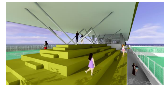
↑南西側より観客席を見る 屋根を支える鉄骨丸柱を中央に配置、観客席を囲む手摺を透明のポリカーボネート板にすることにより観戦のしやすさを考慮
