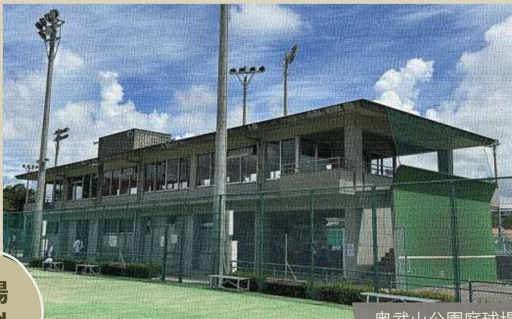
奥武山公園庭球場管理棟
