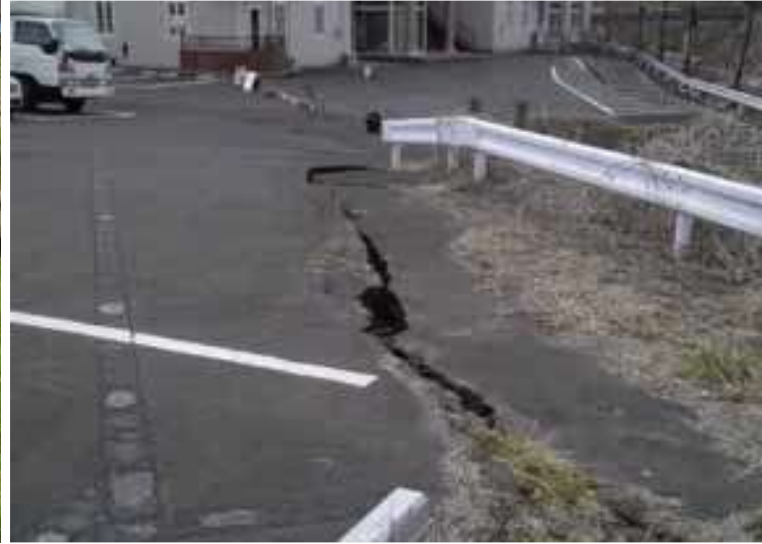
(b)のり肩の亀裂の事例
