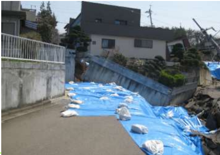
(c)腹付け盛土の崩壊の事例
