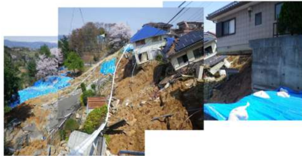
(d)液状化による側方流動の事例
