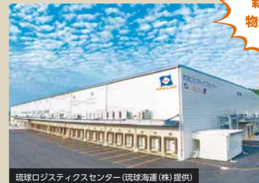
琉球ロジスティクスセンター(琉球海運(株)提供)
