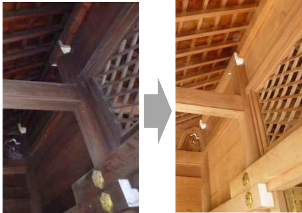
伝統手法である「木部灰汁洗い」 木を削ることなく建てた当初の風合いや木の香りを よみがえらせます。
