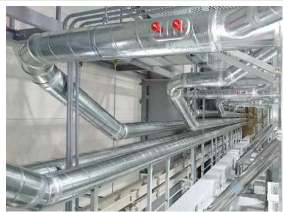
集塵ダクト設置工事現場
