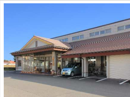
法人管理棟外観
