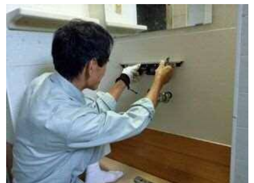
浴室シャワー水栓の取り付けをする川添さん
