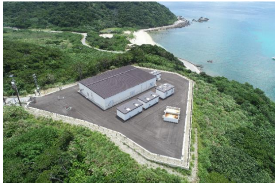
離島海水淡水化施設（座間味村阿嘉島）
