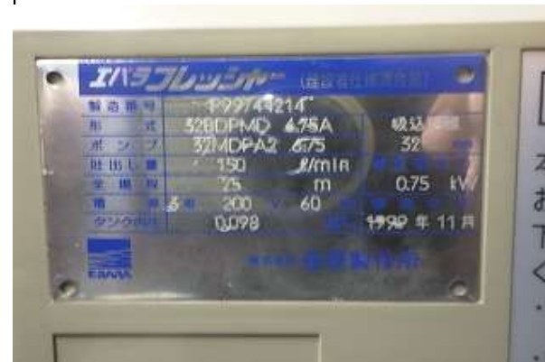
中水加圧ポンプ(プレート)
