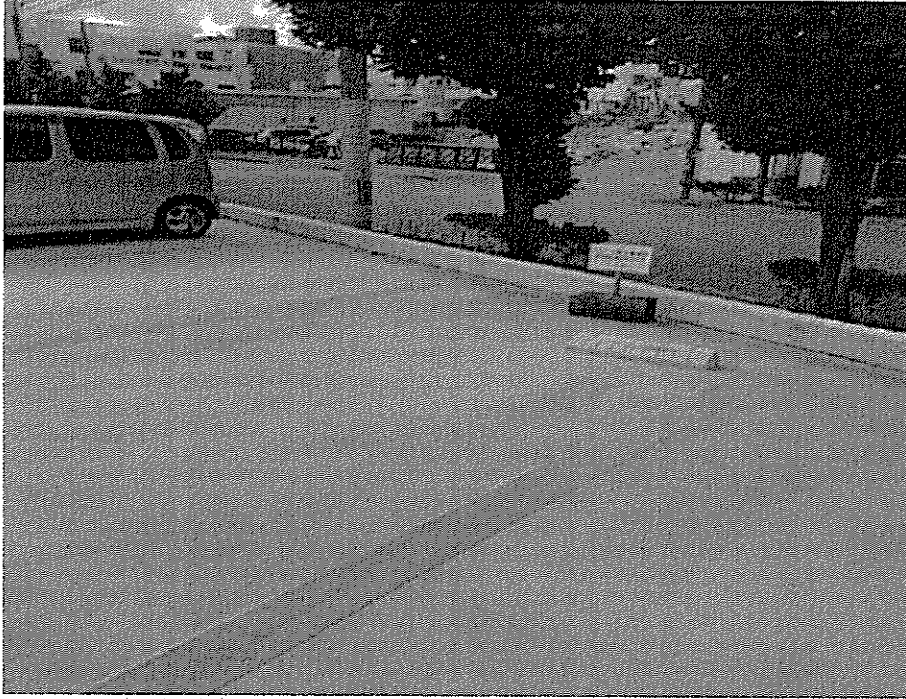
政務事務所 来客用駐車場 外観
