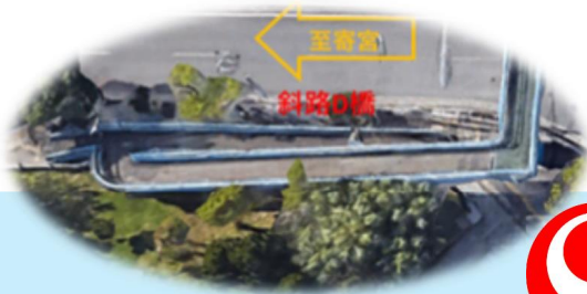
与儀公園前歩道橋
