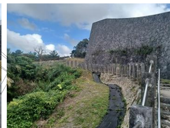
城壁外東階段エリア
