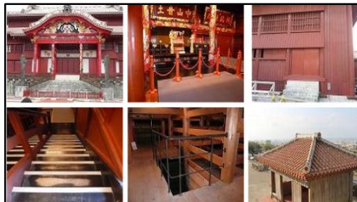
正殿内外 (火災・避難状況確認)
