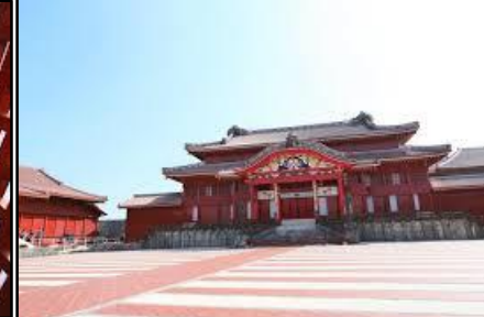
正殿外 (火災・避難状況確認)
