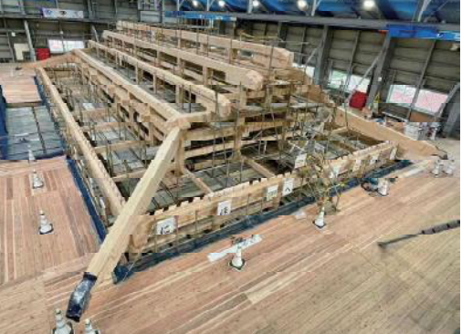
正殿工事 軸組建方完成(令和5年12月)
