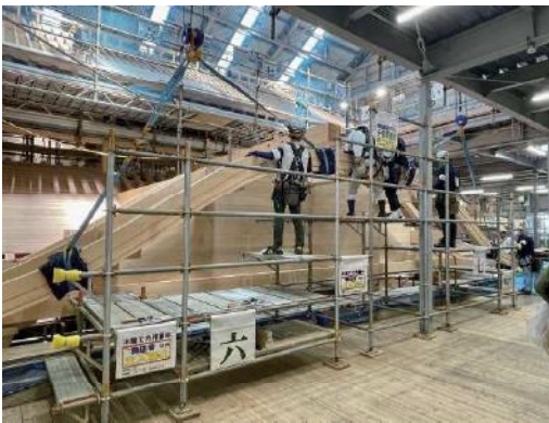
肩成風(正殿2階正面)取付作業の様子(令和6年5月)
