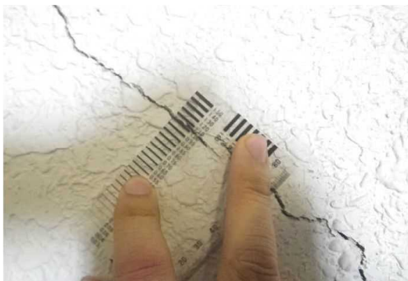
写真. ひび割れ幅の測定
