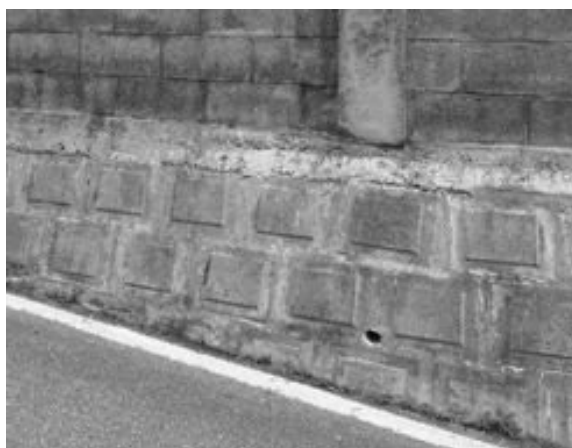
間知ブロックの擁壁
