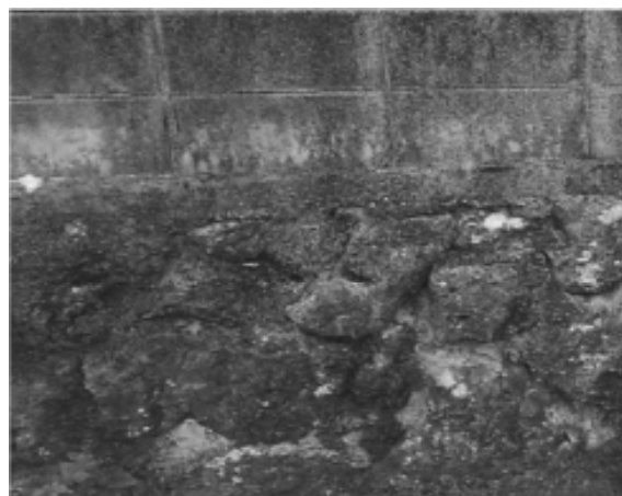
自然石積みの擁壁
