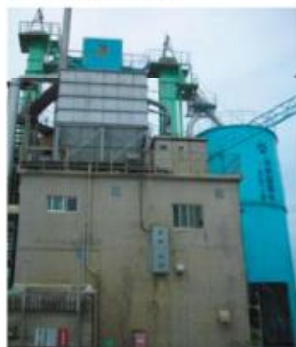
生石灰製造設備
