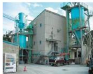
消石灰製造設備
