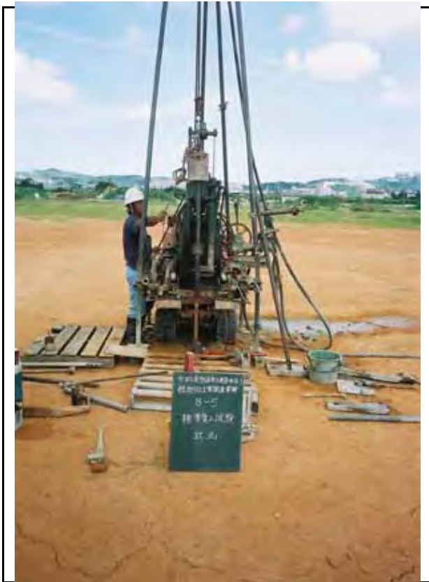
標準貫入試験状況
