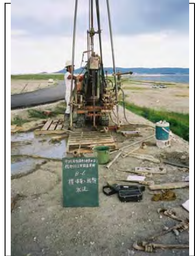
標準貫入試験状況
