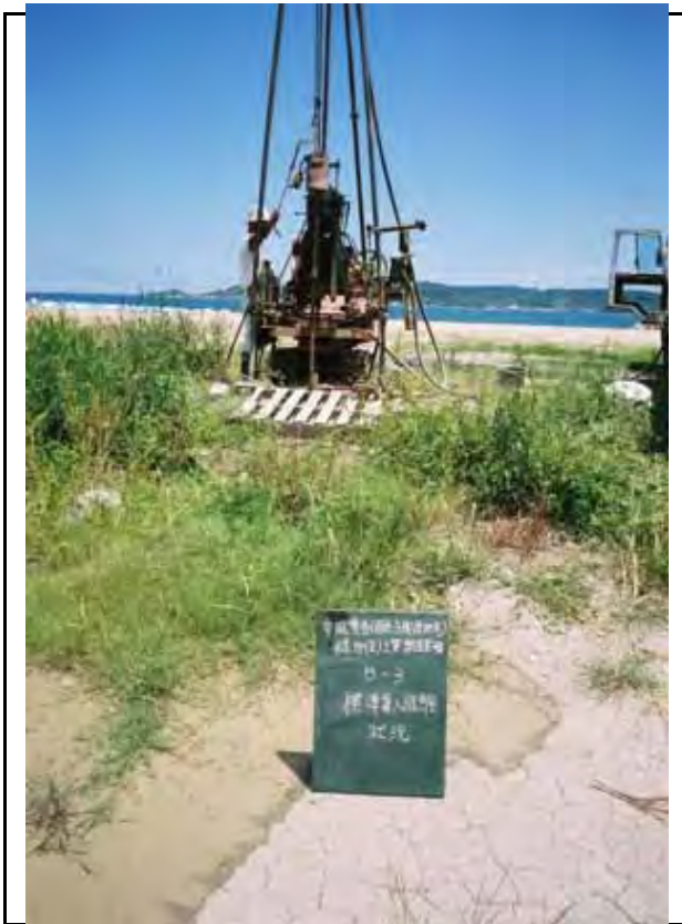
標準貫入試験状況
