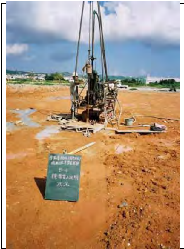
標準貫入試験状況
