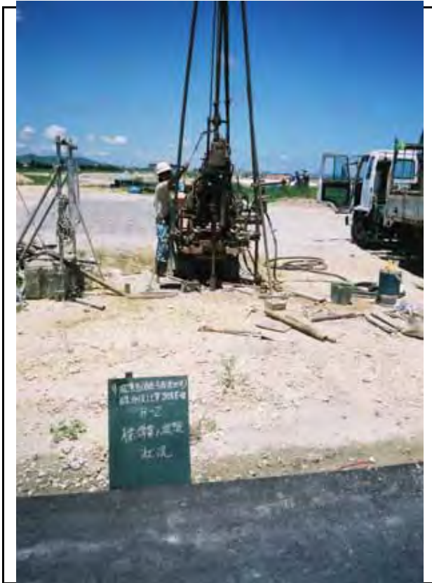
標準貫入試験状況
