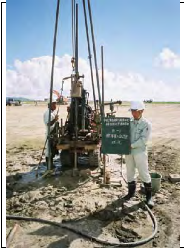
標準貫入試験状況
