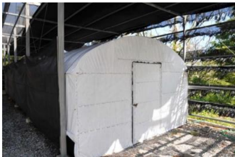
図-20. 菌床しいたけ発生ハウスの設置例（名護市大中、森林資源研究センター旧施設内）
