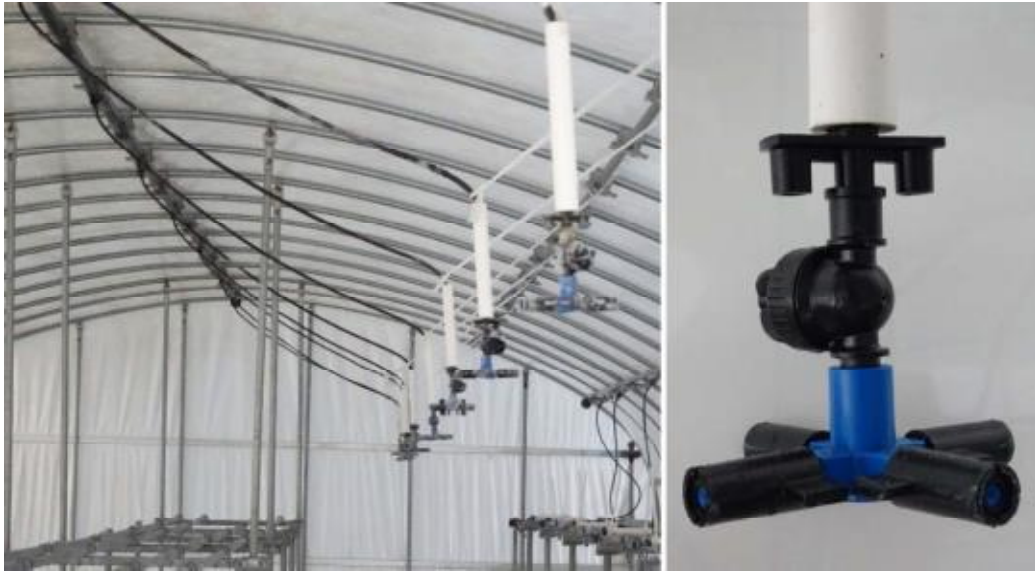
図-23. スプリンクラーの設置例
