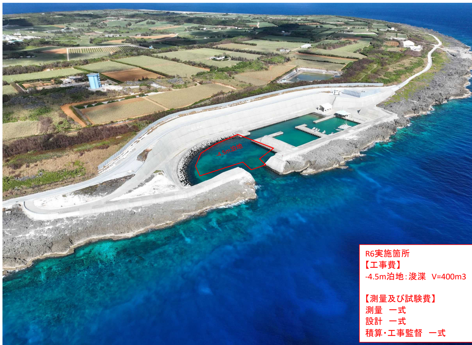
南大東漁港 第四種 県管理 平成19年指定 令和4年撮影
