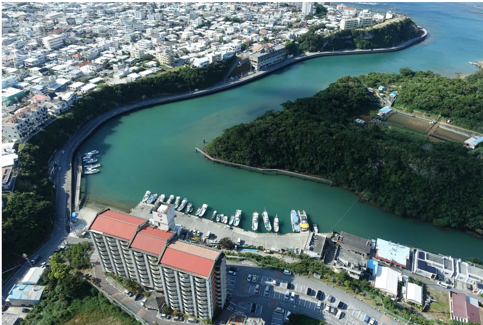
嘉手納漁港 第1種 沖縄県管理 平成27年12月 撮影
