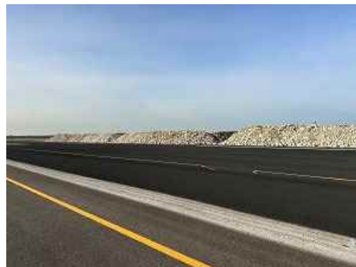
撤去工事等の碎石を仮置き ※憩いの空間として活用予定
