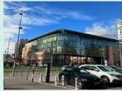
新設建築物の様子
