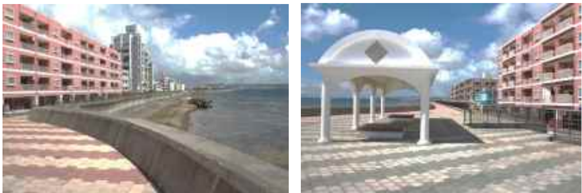
図Ⅱ-5 宮城海岸の護岸を活用したプロムナード
