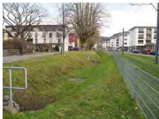
図Ⅶ-11 地区内の雨水流下の調整池
