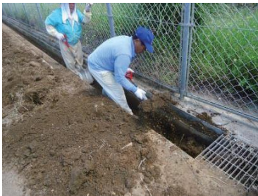
排水路の土砂上げ
