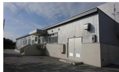
冷蔵配送センター施設 (平成 27 年度竣工)
