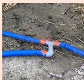
基幹部フラットホースの部品と組み立て
