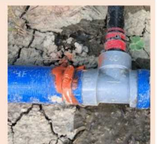
穴開チューブの接合部と組み立て
