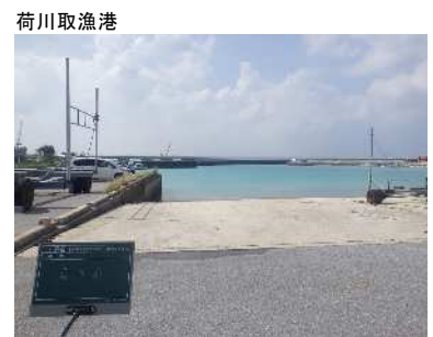
改良前の船揚場
