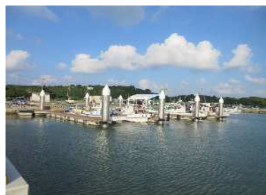
改良後(浮棧橋)
