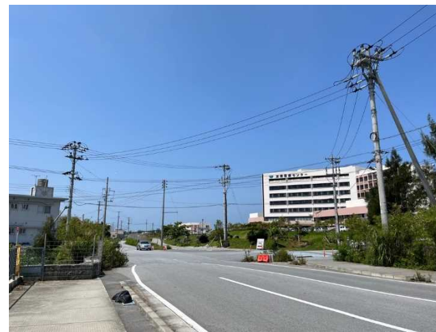
予算確保が十分でないため、やむを得ず車道部未改良のまま供用開始を行っている状況。
