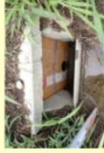
排水調節板の設置
