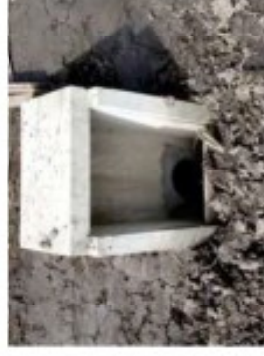
落水口の整備
