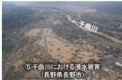
【令和元年東日本台風】
