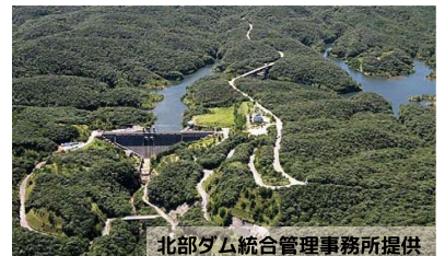
北部ダム統合管理事務所提供 普久川ダム (1983年完成)
