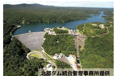
北部ダム統合管理事務所提供 福地ダム (1974年完成)
