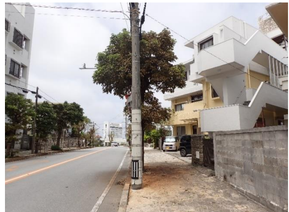
写真 1-4 道路舗装への被害（汚れ）
