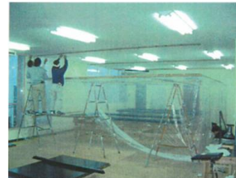
⑲ 上塗り用間仕切ビニルフィルム設置状況
