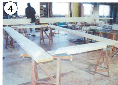
仮組検査 (H13.11月)
