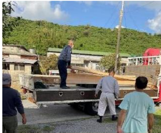
材の荷下ろし
