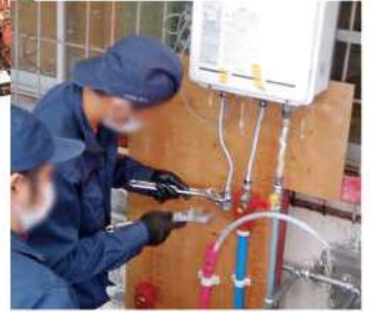
ガス設備施工実習
