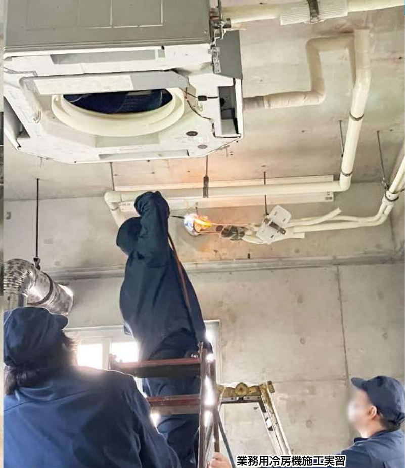
ピット内での配管作業
