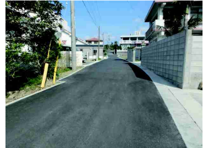
農村集落基盤再編・整備事業 (集落道整備)
