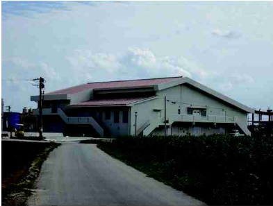
農業集落排水事業（汚水処理施設）
