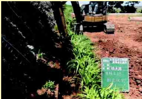
排水路の維持管理作業
