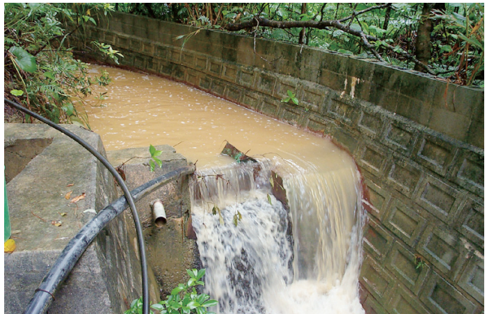
陸軍複合射撃訓練場造成工事現場からの赤土流出(平成16年9月)
