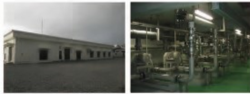
並里・金武1期地区(H28完了)
