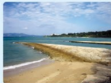
農山漁村活性化プロジェクト支援交付金 安富村地区(22完了)
