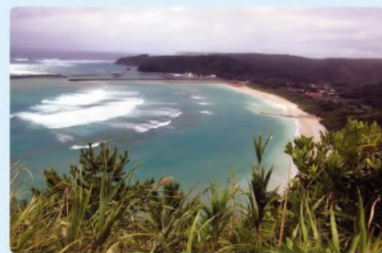
海岸保全施設整備事業 (高潮) 安田地区 (完成後)
