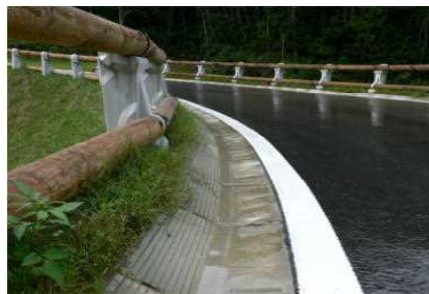
改良型L型側溝 (チイバナ林道)
