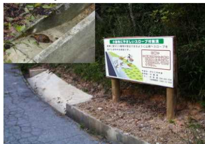
スロープ型側溝 (伊江II号林道)
