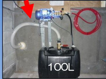
高空気圧ポンプとタンク
