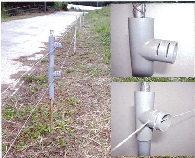
塩パイプと鉄筋を利用した手作りのポール
