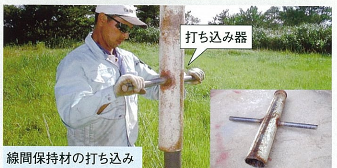
大口径の鉄パイプを利用した打ち込み器があれば便利です。
