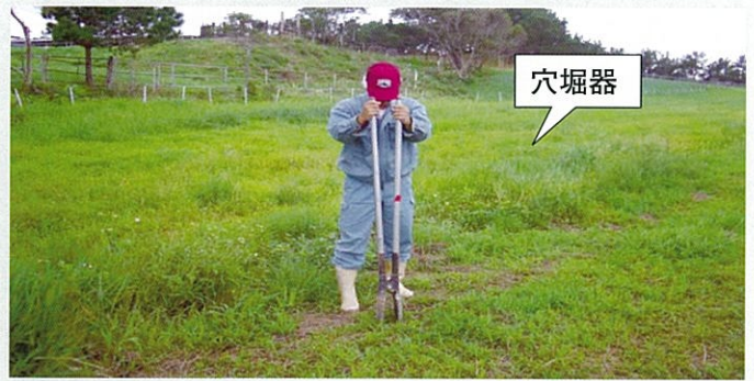
深さ約80cm穴を掘ります。穴掘器を使って約10分ぐらいかかります。
