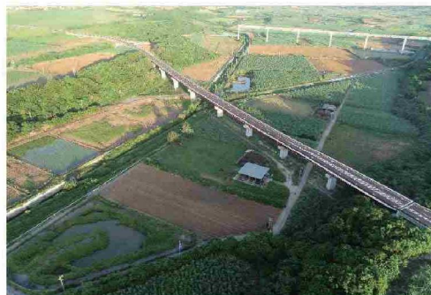
石垣空港線 下田原大橋
