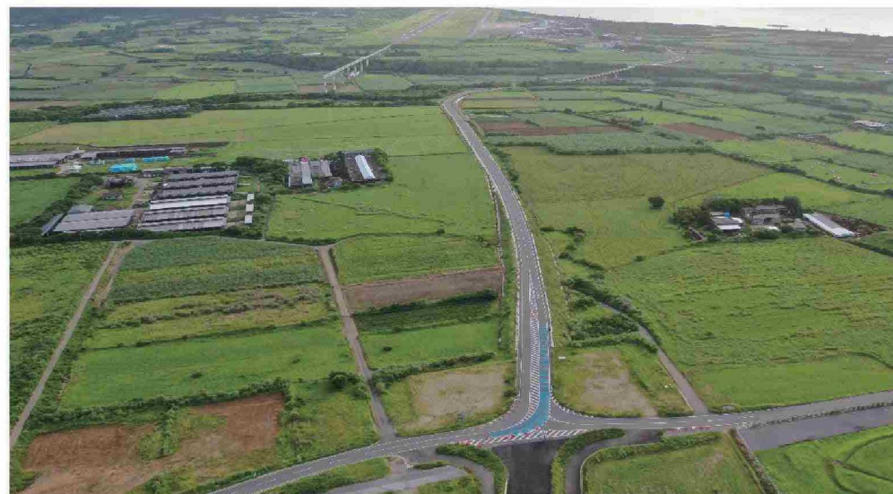
石垣空港線R3年度部分供用箇所(市道宮良産業道路から空港方向)
